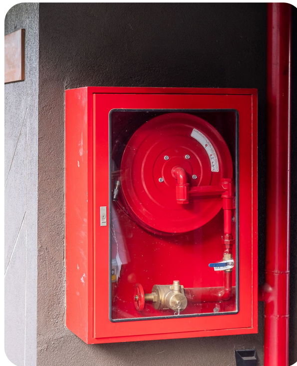
Проверка выходов, систем пожаротушения и т.д.
